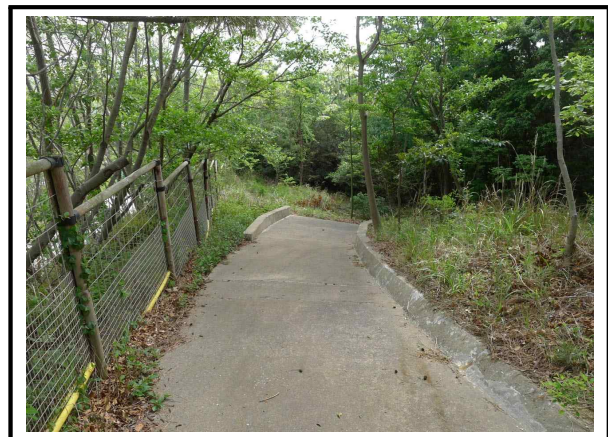
사진번호 84 종점부 사면 소단 배수로 상태양호 외관망도 -
