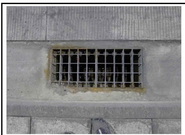
사진번호 11 배수시설 전경 외관망도 -
