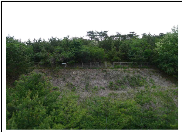
사진번호 79 종점부 사면 표면보호공 상태양호 외관망도 -
