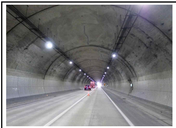
사진번호 7 터널 내부 전경 외관망도 -
