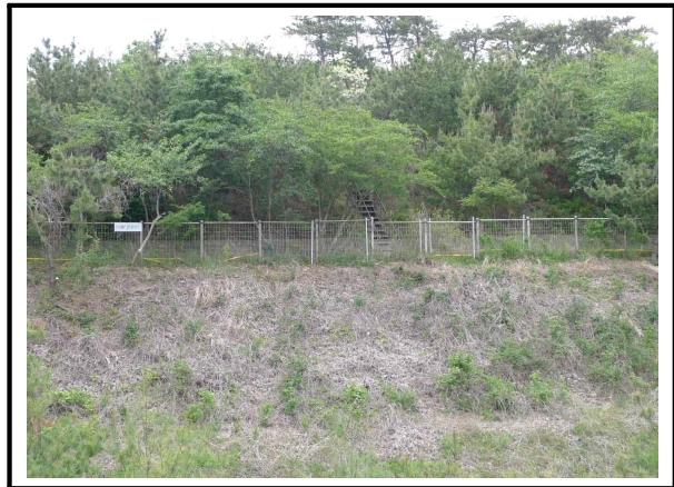
사진번호 92 사면 내 점검계단 설치현황 외관망도
